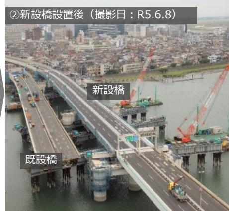
延長約300mの新設橋を既設橋の位置へ移動して架設
