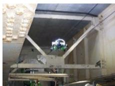
桁間に設置したロープ上を装置が移動しながら損傷把握
