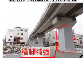
耐震補強例(金石高架橋)
