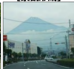
電線類による景観阻害
