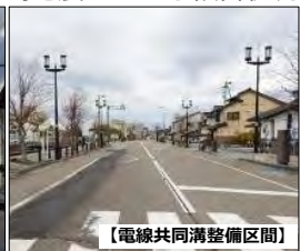
【電線共同溝整備区間】 電線類の断線は発生していない
