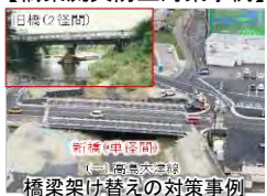
橋梁架け替えの対策事例
