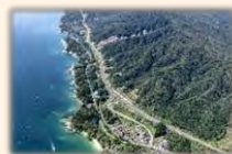
三陸沿岸道路 (岩手県山田町)
