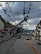
電柱等の倒壊
