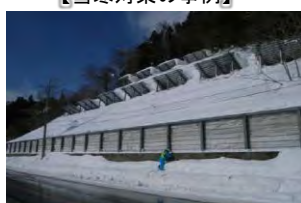
雪崩対策の例(雪崩防止柵)
