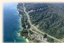
三陸沿岸道路(岩手県山田町)
