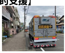
路面下空洞調査
