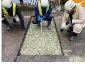
空洞補修工事
