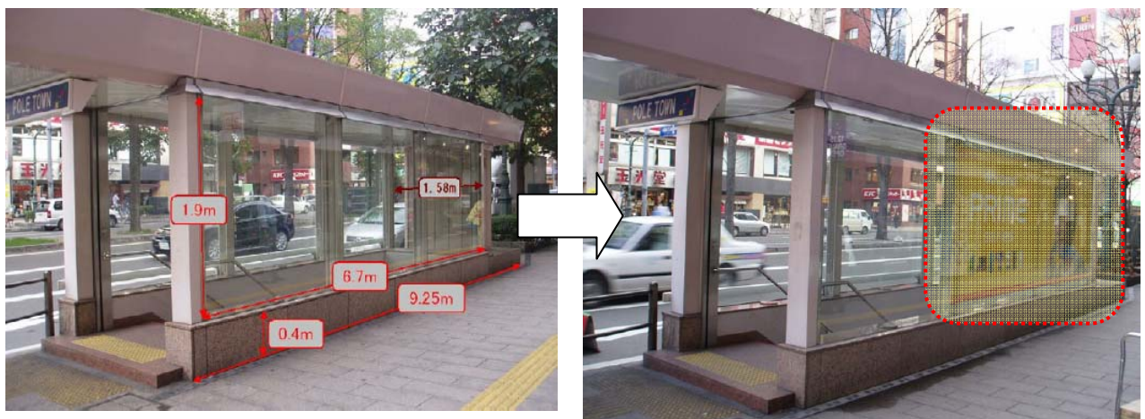
図 3-11 札幌市における地下鉄出口への広告物の掲出事例
