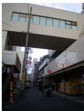
④廃止市道と上空通路 (左3号館、右2号館)
