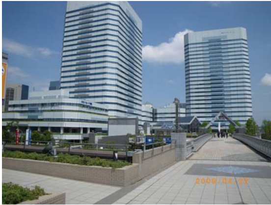
歩行者デッキ上部空間
