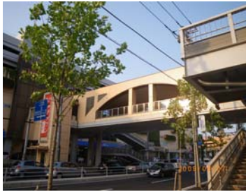
④上空通路(横浜市道上)
