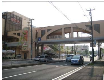
①上空通路(横浜市道上)
