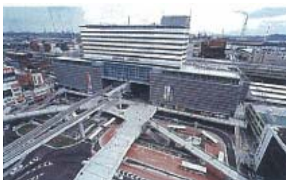
南口駅前広場デッキ
