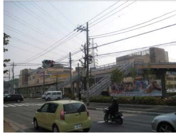
⑤車道と一体整備された横断橋
