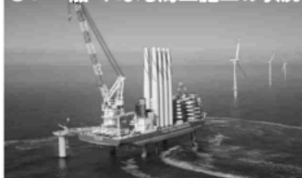
OSEP船 ※ による海上施工の状況
