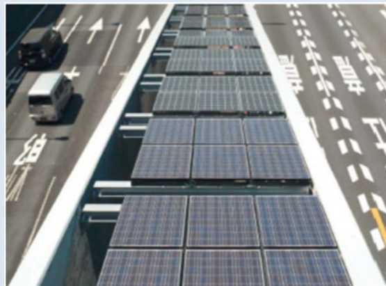
首都高速道路湾岸線東京港トンネル坑口付近 （ https://www.shutoko.co.jp/efforts/environment/technology/solarpower/ ）
