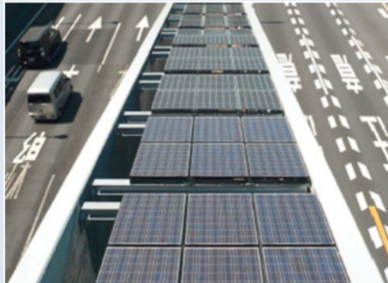
首都高速道路湾岸線東京港トンネル坑口付近
