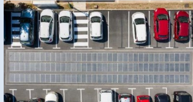
駐車場路面の太陽光発電舗装
