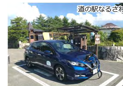
道の駅でのEV充電施設の設置
