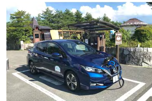
< 道の駅でのEV充電器の設置 >
