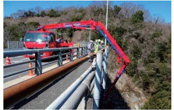
写真－1 点検ロボットによる橋梁点検
