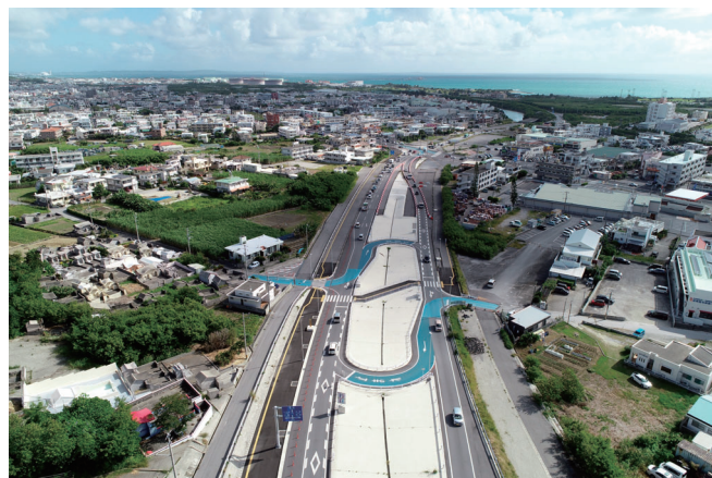
町道与那原 6 号線と交差する町道与那原 6 号線交差点 (令和 4 年 10 月 29 日撮影)
