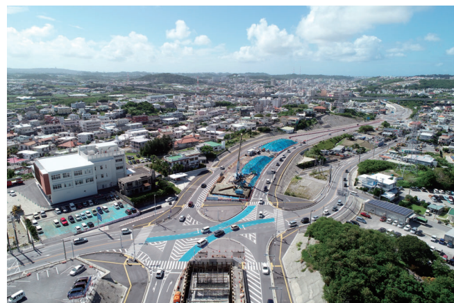
県道 240 号線と交差する東部消防前交差点 (令和 4 年 10 月 29 日撮影)
