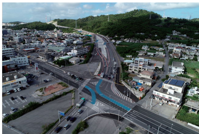
国道 329 号と交差する与那原北交差点 (令和 4 年 10 月 29 日撮影)
