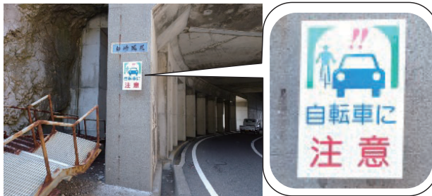
注意喚起の看板（狭小トンネル）
