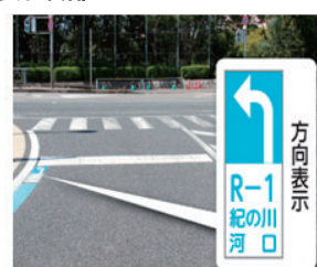
交差点直前に、進行方向等を示す路面表示(方向表示)を設置
