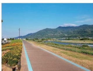
道路の両端にブルーライン(実線)を設置
