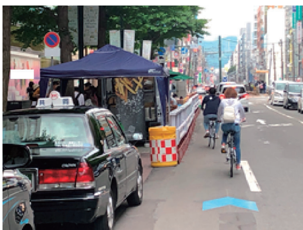
写真9 矢羽根型路面標示の設置
