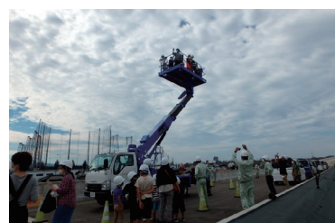
高所作業車から仕上がりを確認 子供達から大人気
