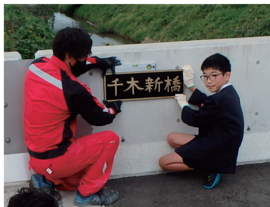
橋名板の設置状況
