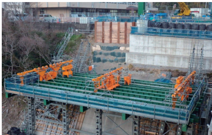
【写真④】 仮設構台
