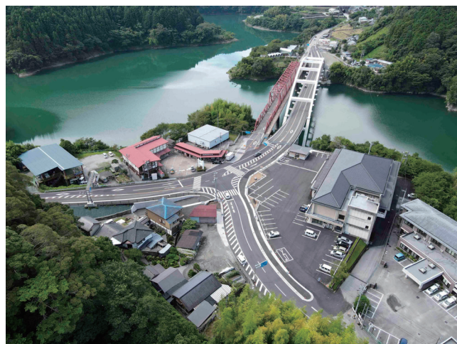
【写真③】 完成写真
