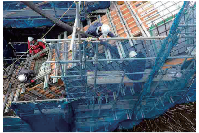
【写真⑨】根巻コンクリート打設状況
