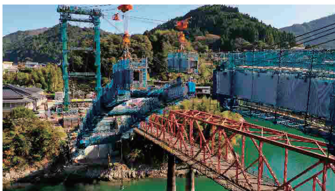
【写真⑤】 鋼アーチリブ架設状況
