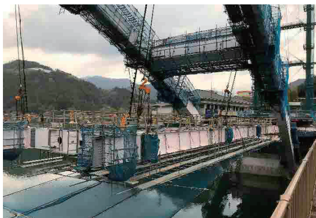
【写真⑥】補剛桁架設状況
