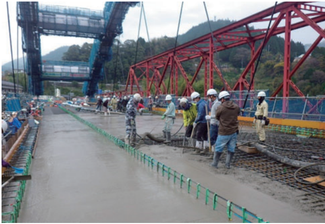
【写真⑧】床板コンクリート打設状況
