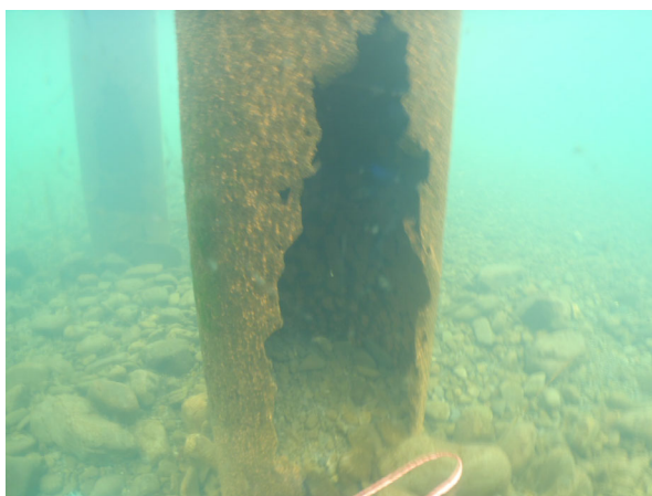
断面欠損部はグラウトを注入し応急対応
