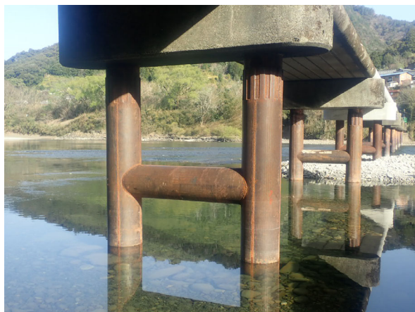
鋼製当て板工法の採用
