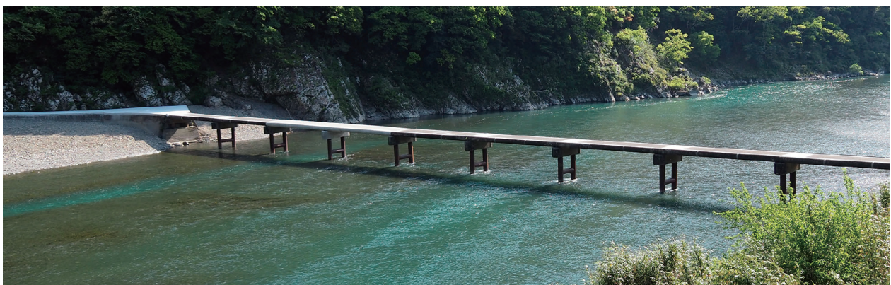
岩間大橋復旧前・復旧後
