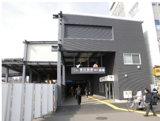
仮駅舎（完成・供用開始）
