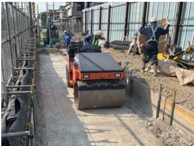
仮線路盤施工状況 1
