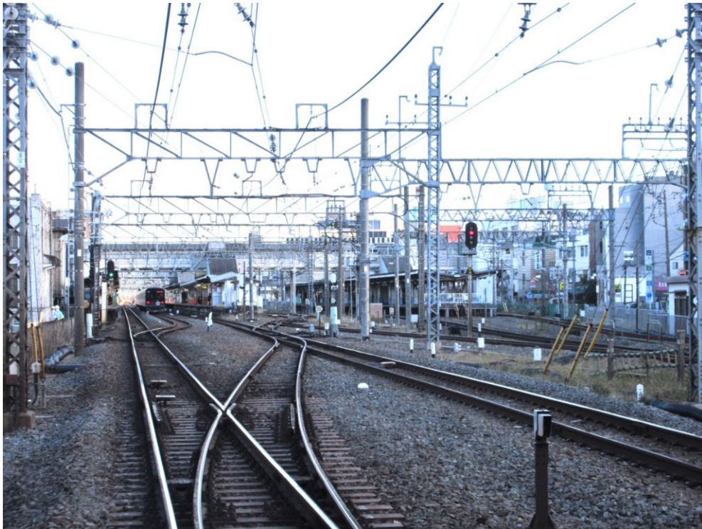
春日部駅全景（北春日部方から撮影）
