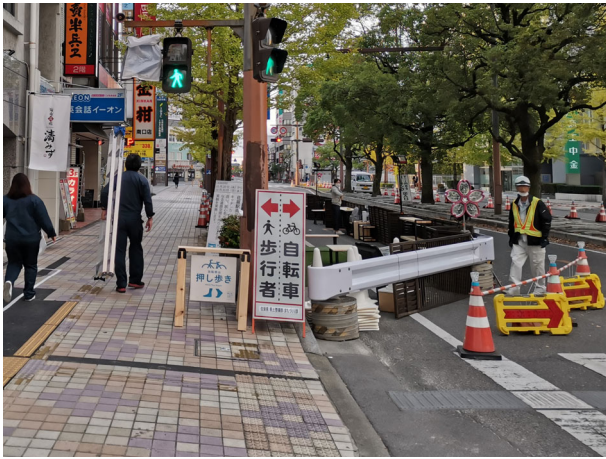
【写真 06】仮設ガードレールと交通誘導員
