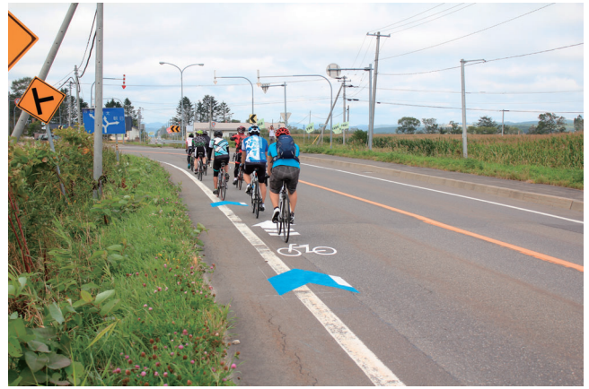
写真2 路面への通行位置明示
