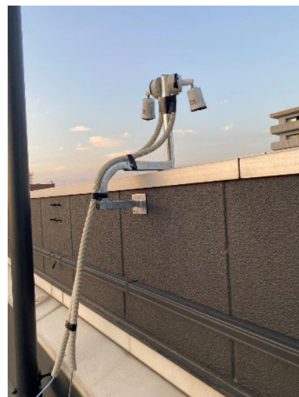
【写真15】カメラ設置状況
