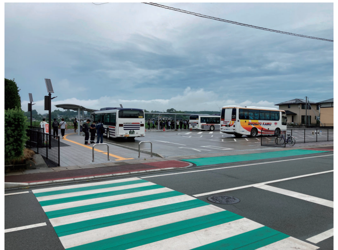
整備後の原水駅北口バス転回広場の状況
