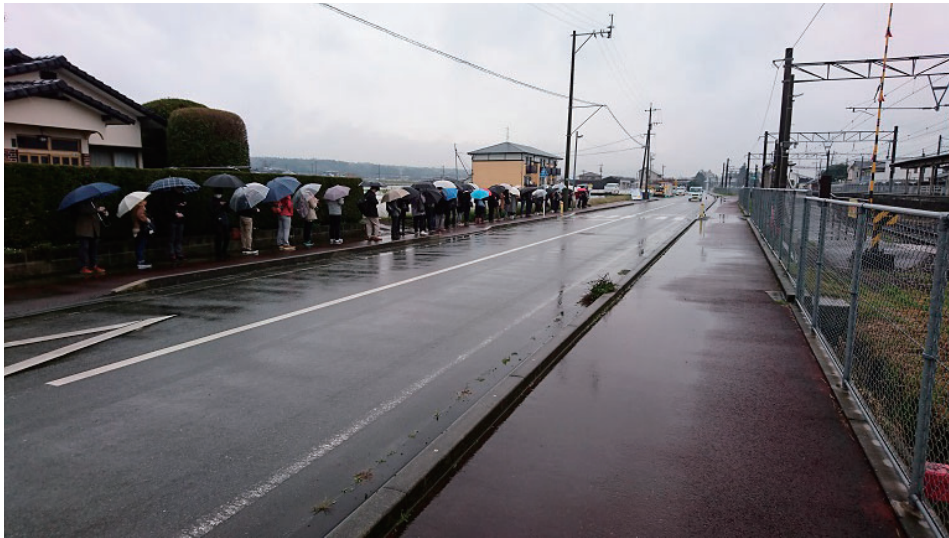
整備前の原水駅北口バス停留所の状況
