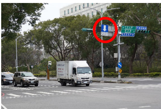
⑤リバーシブルレーンの整備状況 (中央分離帯がある区間でも実施)
