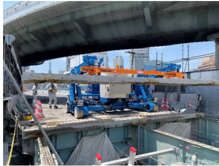
図-3② 専用機械による既設コンクリート床版の撤去状況
