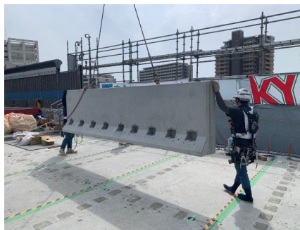
図-3⑤ プレキャスト高欄・中央分離帯の設置状況
