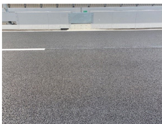
図-6③ ジョイントレス化後の状況
