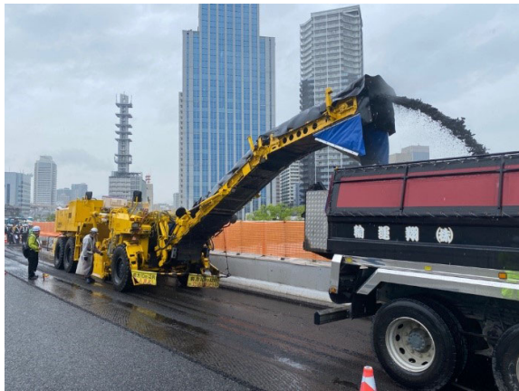
図-5② アスファルト舗装の撤去状況
