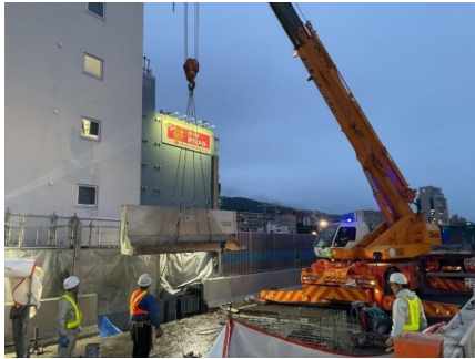
図-3① 高欄・中央分離帯の撤去状況
