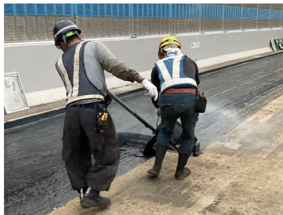
図-5③ 高性能床版防水の施工状況
