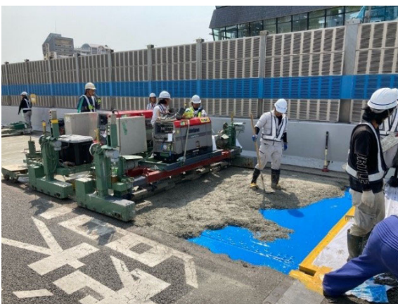
図-4① SFRCの施工状況
