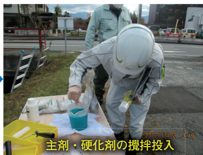
写真8 BOXひび割れ塗布補修の流れ
