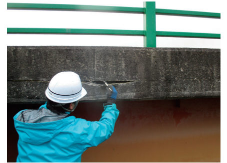
写真2 地覆の断面補修
