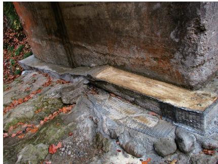
写真3 洗掘による橋台欠損部の断面補修
