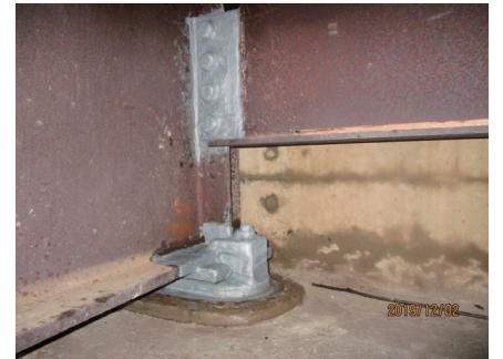
写真5 防食材貼付による支承補修
