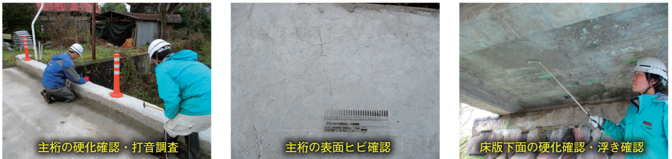
写真9 主桁・床版の断面補修後のモニタリング
