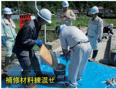
写真6 主桁の断面補修の流れ
