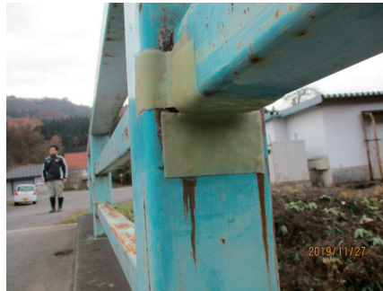
写真4 紫外線硬化型シートによる高欄腐食部補修
