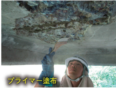
写真7 床版下面の断面補修の流れ
