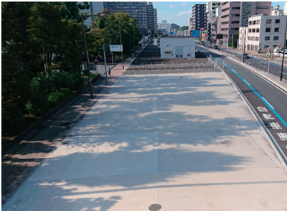
通常時のコンクリート舗装
