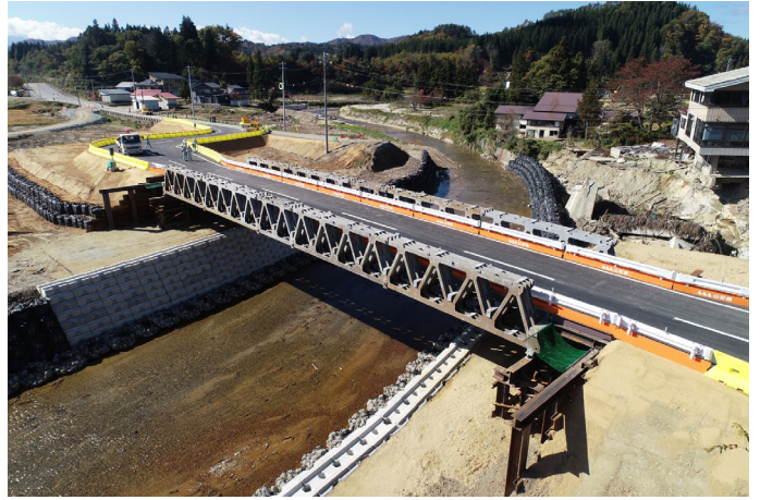
写真 7 完成状況（左岸側から）
