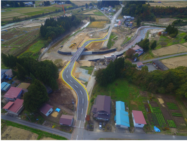
写真 6 完成状況（上空から）
