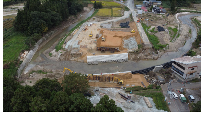
写真4 路体盛土と護岸工の施工状況
