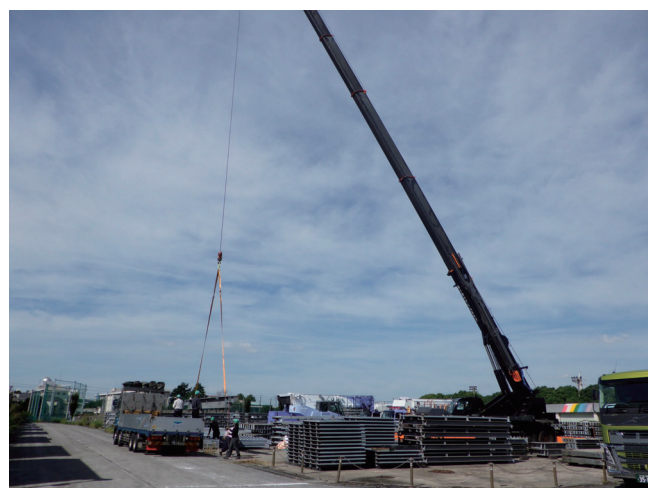
写真3 応急組立橋の搬出
