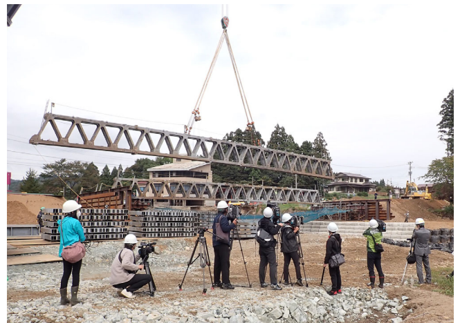
写真5 応急組立橋架設（報道公開）
