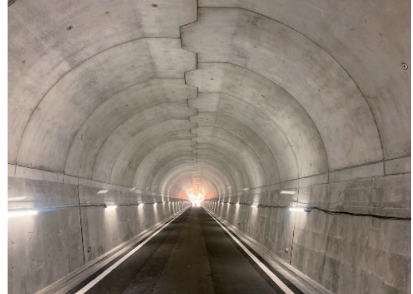
写真11 仁方隧道坑内
