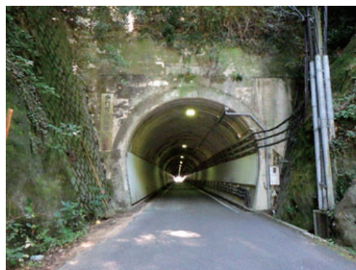
写真1 仁方隧道終点側坑口
