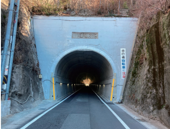
写真10 仁方隧道坑口
