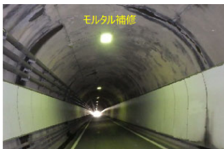
写真4 モルタル補修状況
