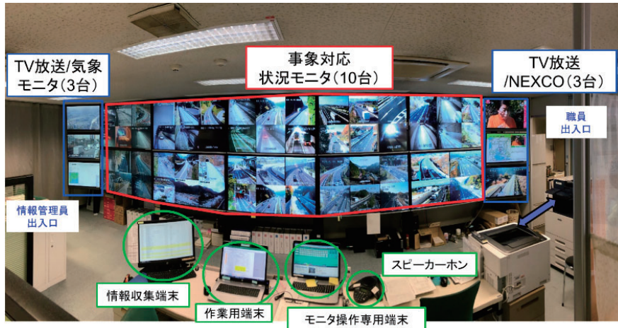
図ー 3 高規格道路管理センターにおける情報収集の状況
