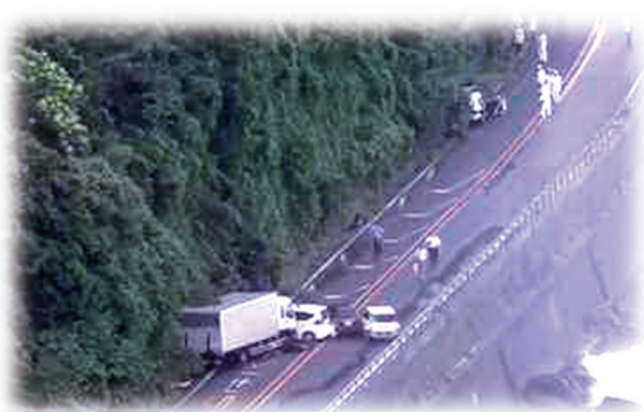
国道135号（江之浦地先）高波被害直後
