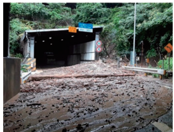
図-3 令和4年8月の大雨時の状況
