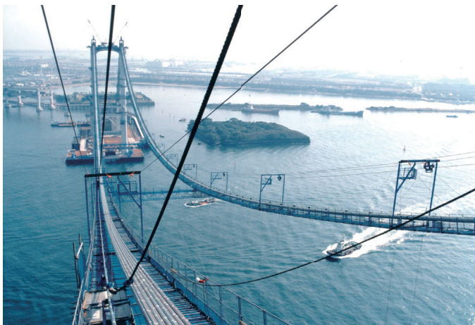
写真-3 キャットウォークによるケーブル架設
