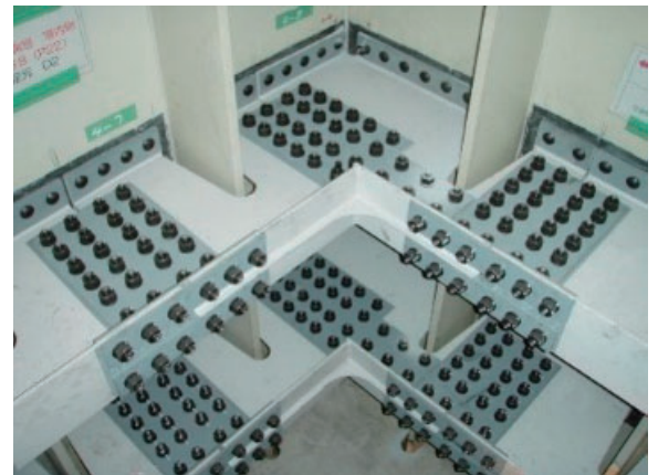
写真-9 側塔横リブ補強
