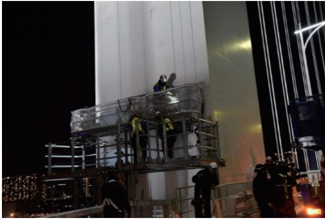
写真-14 ゴンドラによる塔柱部の施工状況
