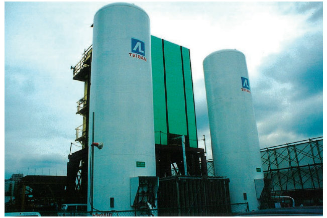
写真-2 液体窒素による骨材冷却プラント
