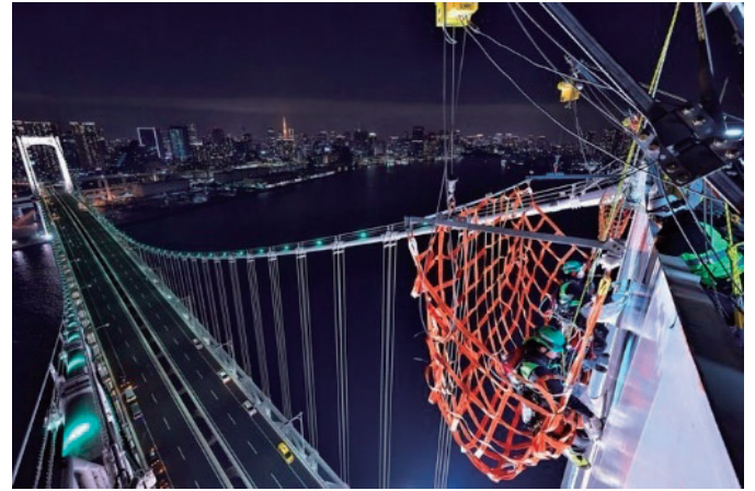
写真-15 ロープアクセスによる塔頂水平部の施工状況
