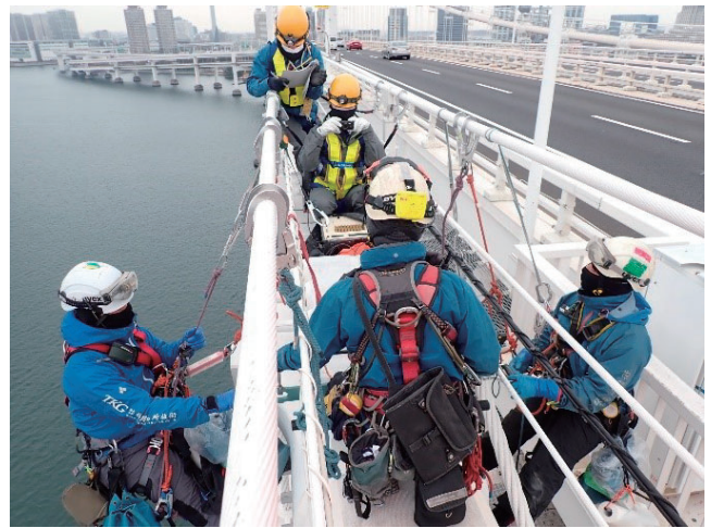
写真-8 ケーブルバンド締付ボルト軸力計測
