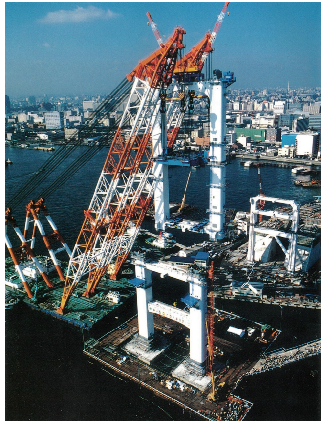
写真-4 フローティングクレーンによる主塔の架設状況
