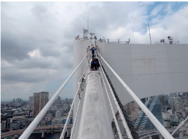
写真-7 主ケーブル目視点検
