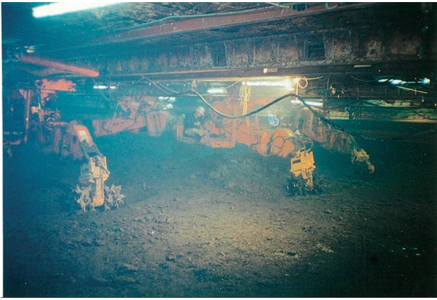
写真-1 無人掘削機による掘削状況
