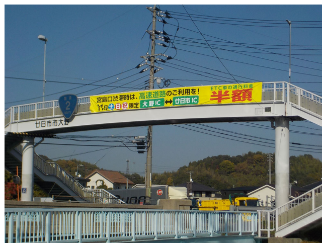
図ー14 横断幕の設置状況写真
