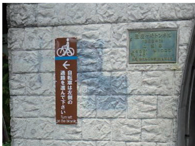
・トンネルを回避するルートの案内標識
