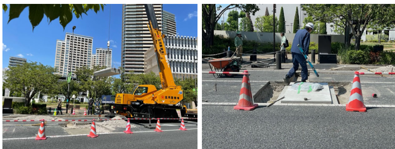
写真-1 コイルが埋め込まれたプレキャストコンクリートの設置状況
