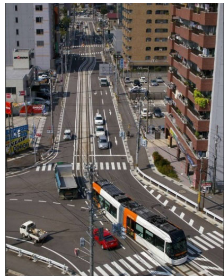
図-3 軌道線形をシフトさせ右折レーンを確保（右：富山ライトレール、左：市内電車環状線化）
