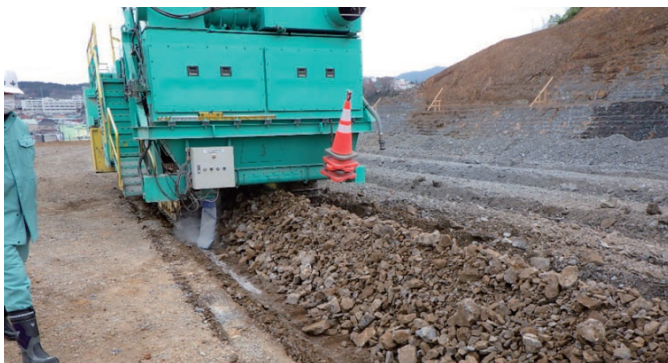
写真-2 軟岩Ⅱ掘削状況
