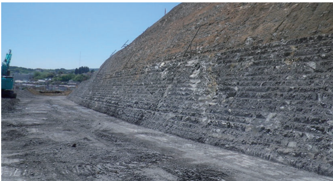
写真-4 掘削後の仕上がり状況
