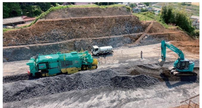
写真-3 中硬岩掘削状況
