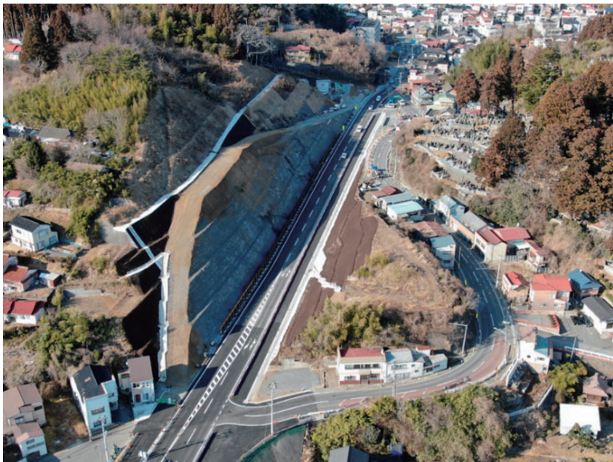
写真－5 事業箇所の状況（令和5年2月）
