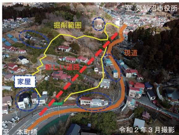
写真-1 事業箇所状況
