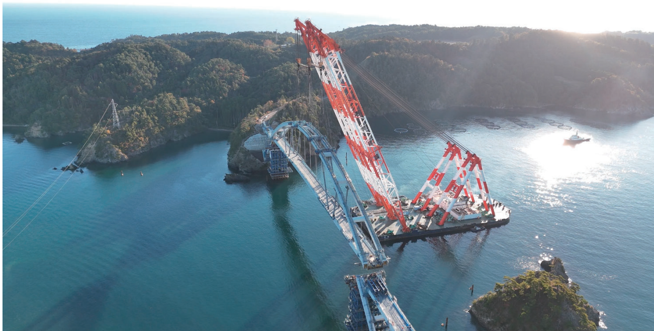
[架橋の架設が佳境に入っています！とMC（令和5年11月16日）]
