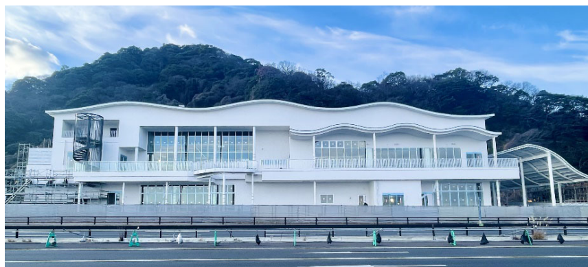
建設中の道の駅「たのうらら」 R5.12月撮影
