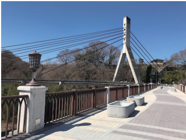
橋面舗装完成
