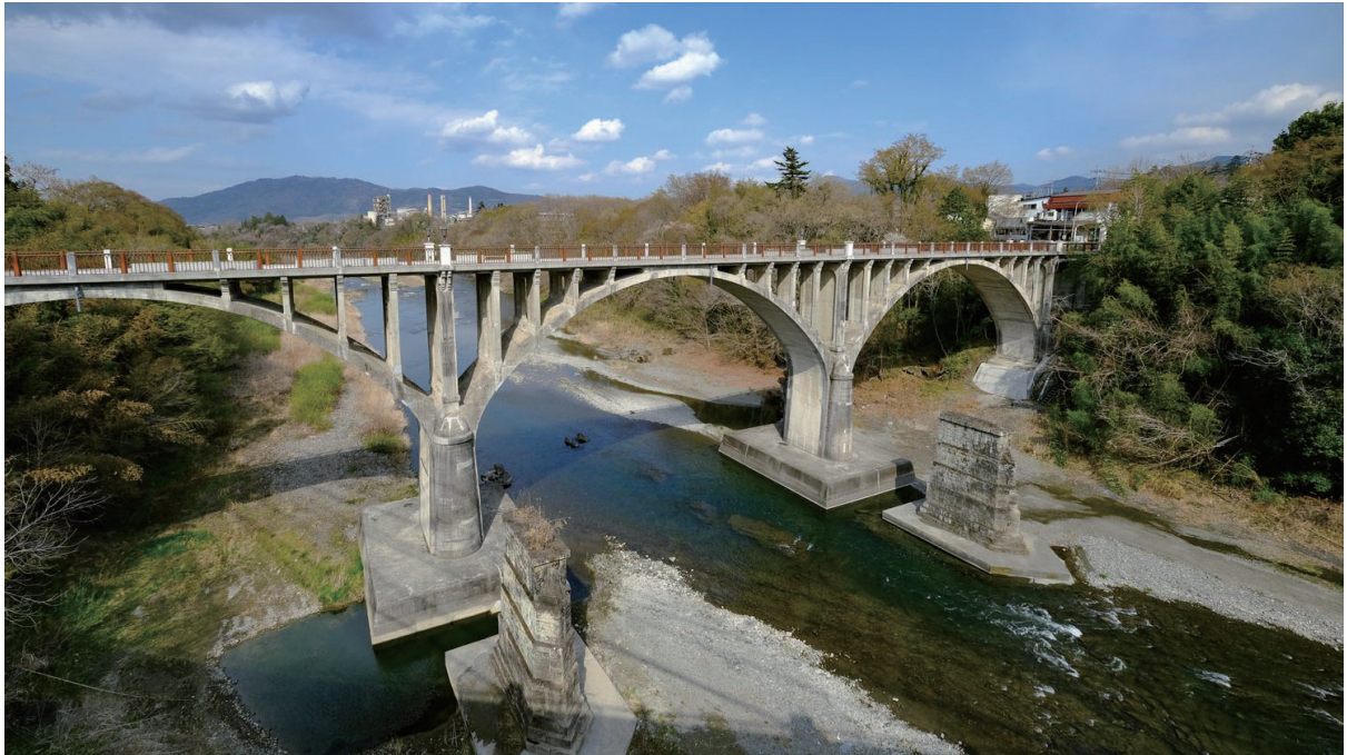
完成後の秩父橋
