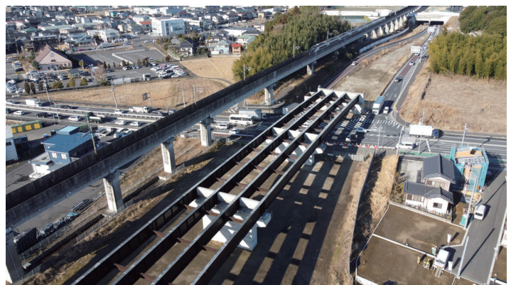
橋梁の施工状況
