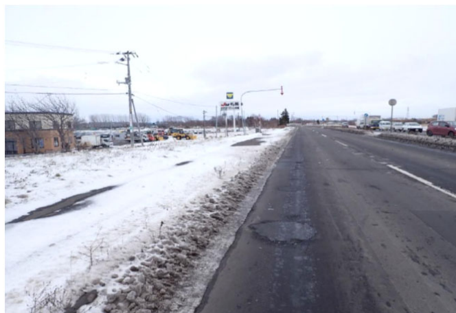
写真8 常温合材による穴埋めの1ヶ月後
