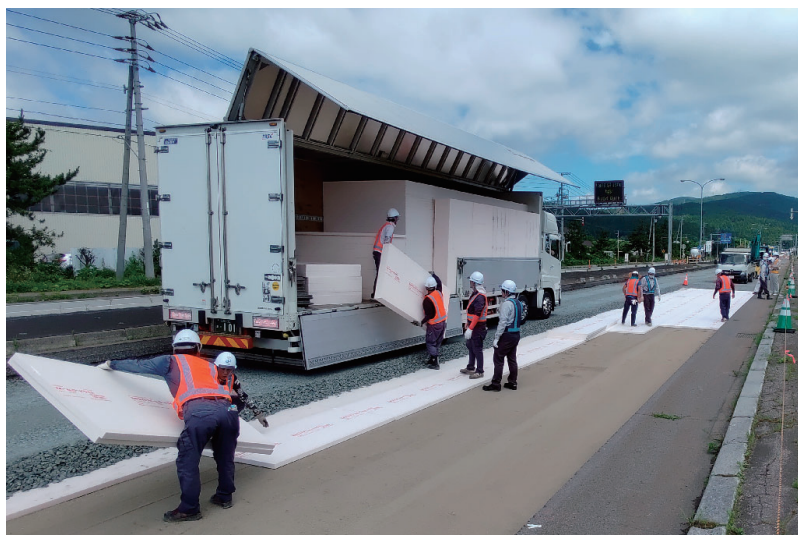
写真4 断熱材工法の設置状況
