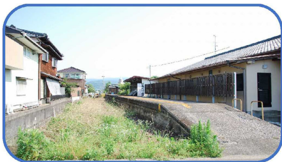
旧浦田観音駅付近（着工前）
