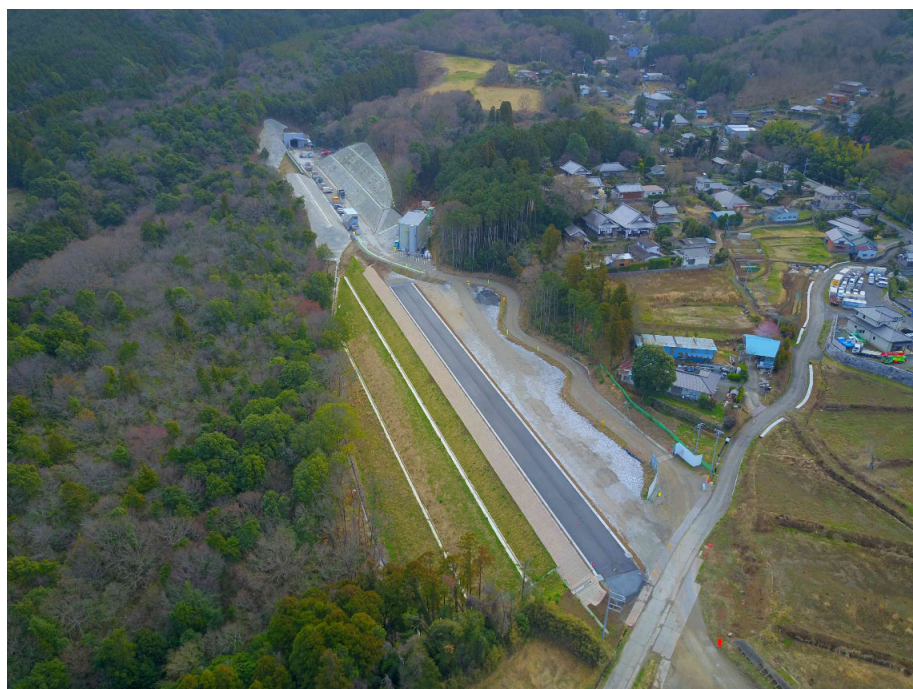
写真－1 上曽トンネル（桜川市側坑口）の状況
