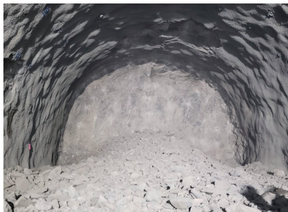
写真－３ 発破直後の掘削断面
