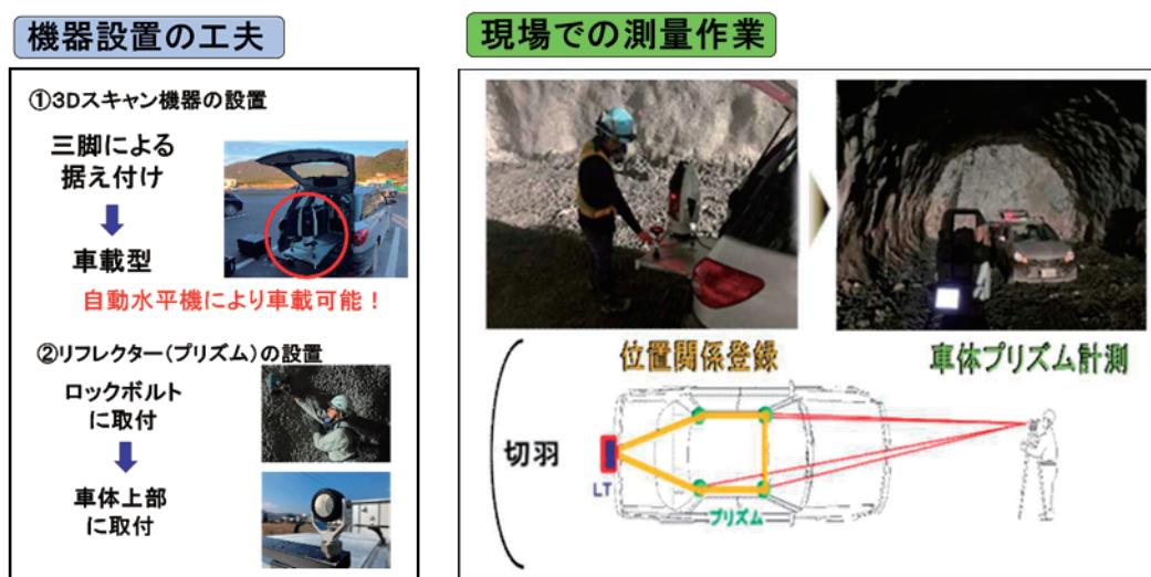
図－6 3D スキャンするための ICT 測量機器設置の工夫と現場での測量作業
