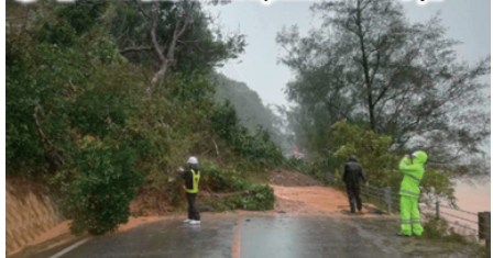
③ 【R5.8被災状況(国道505号)】
