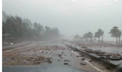
② 【R5.8被災状況(国道449号)】
