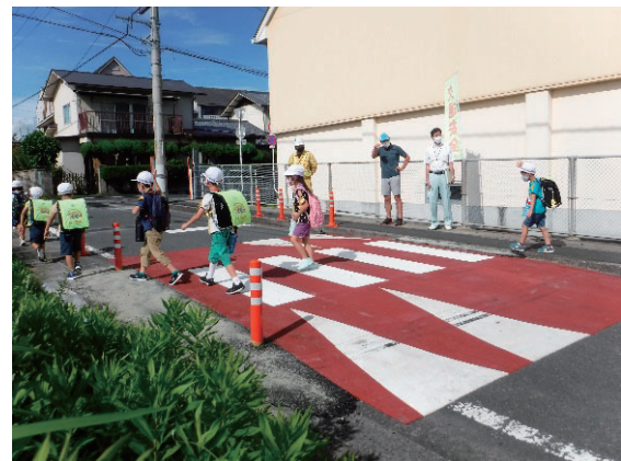
試験設置状況
