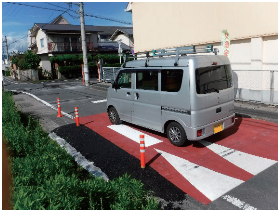
試験設置状況
