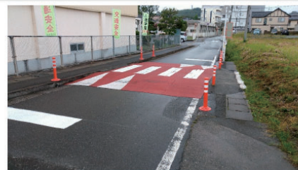
▲スムース横断歩道設置状況
