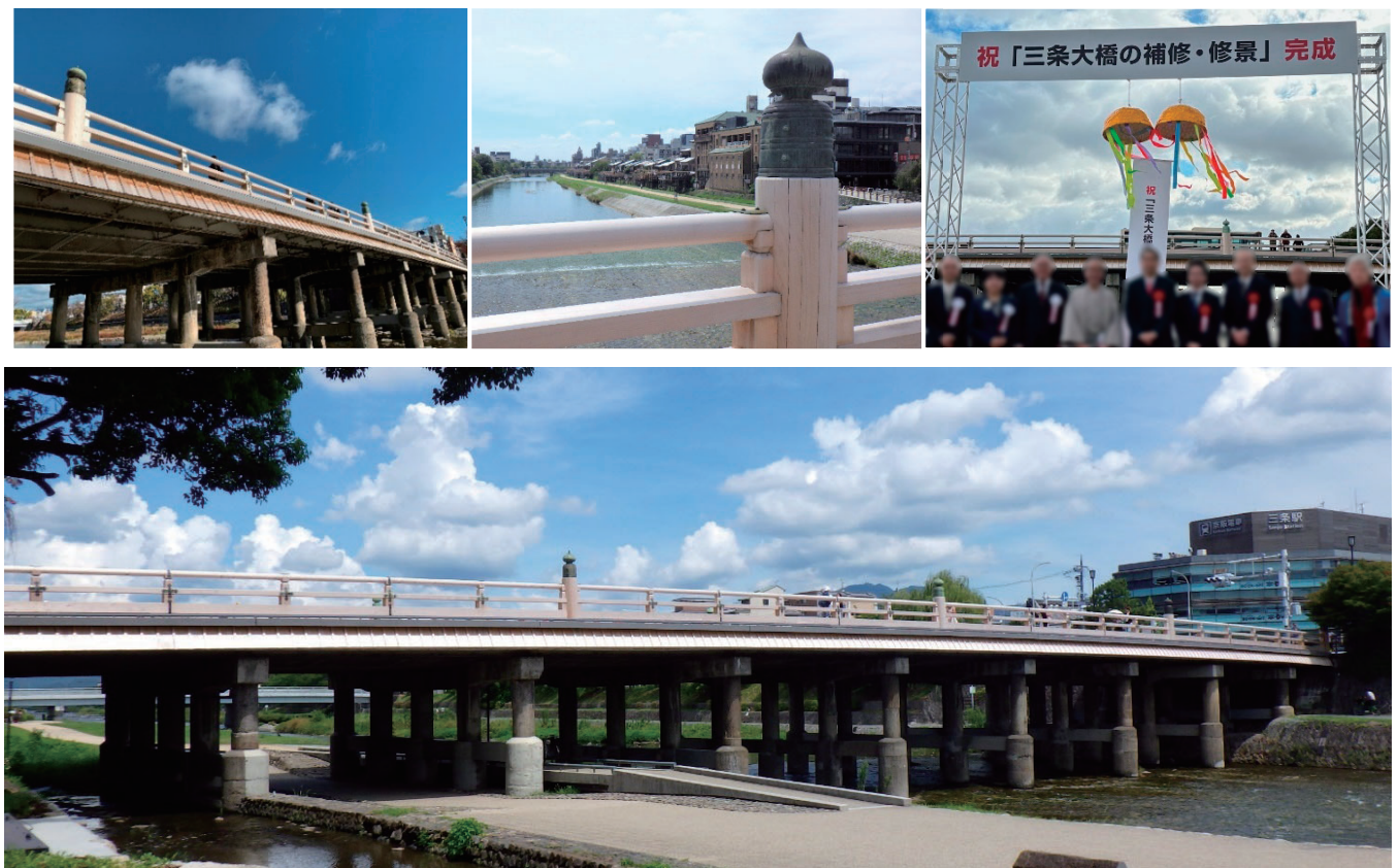
写真－ 6 補修・修景事業が完了した三条大橋
