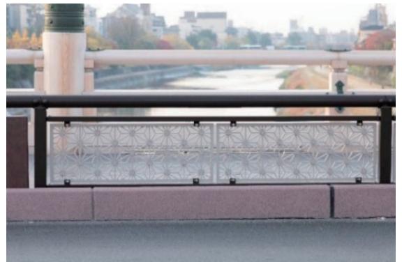
写真－8 歩道舗装・防護柵
