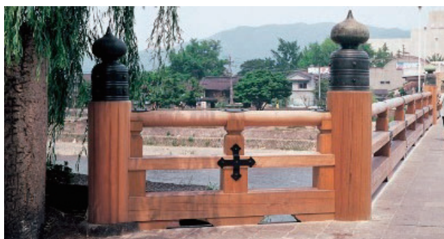
写真－2 木製高欄（昭和49年当時）
