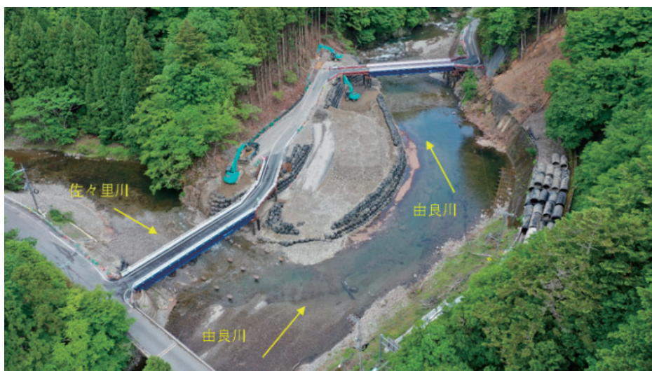
仮橋架橋・渡河部盛土撤去後の状況
