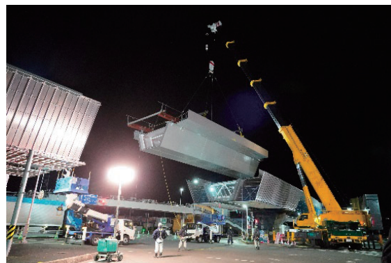
▲国道56号を跨ぐ橋梁架設の様子
