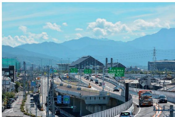
▲開通後の余戸南 IC 付近の様子
