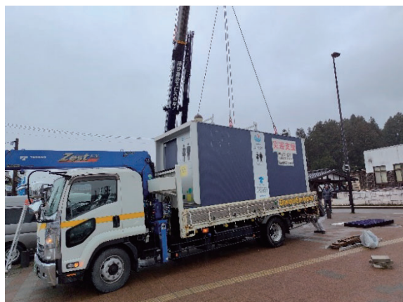
【トラックに積み込みコンテナ型トイレの運搬】
