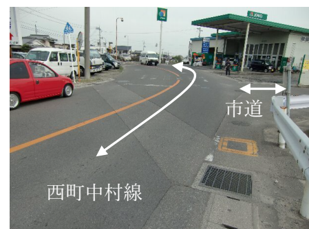
現道の交通事故誘発箇所
