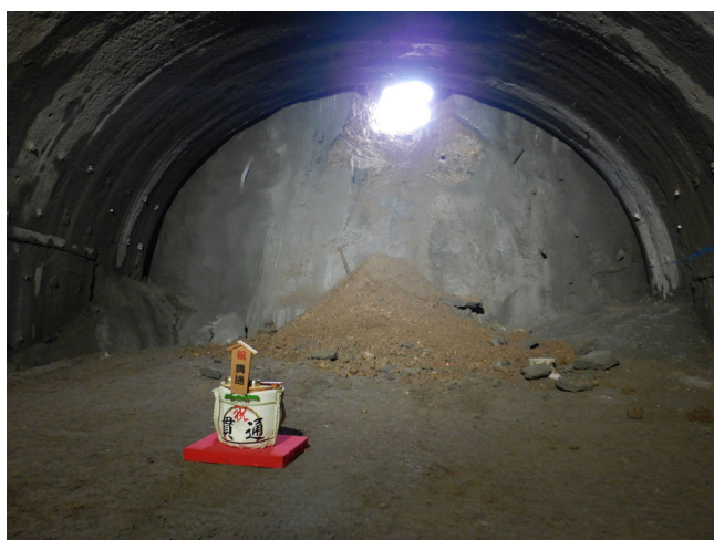
写真①：佐野トンネル貫通（令和５年７月）
