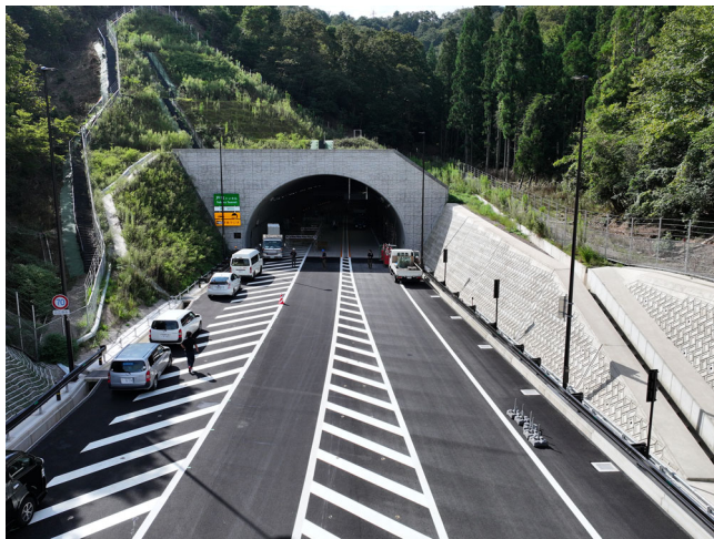
写真③：戸牧トンネル南側（令和6年9月）
