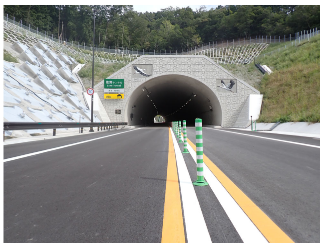
写真②：完成した佐野トンネル（令和6年8月）
