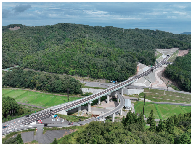
写真①：上佐野高架橋(令和6年9月)
