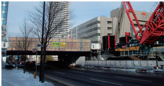
写真2 北海道新幹線札幌駅工事現場と国道5号の高さ3.8m規制
